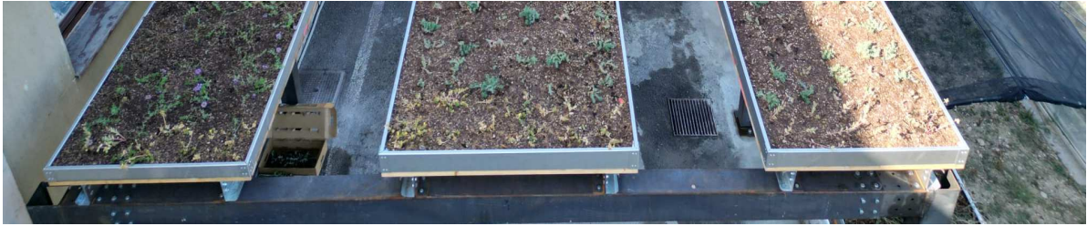
Figura 1- Spessori delle vasche di coltivazione. Da sinistra verso destra lo spessore passa da 8 cm nella zona fortemente ombreggiata in inverno, a 12 cm nella zona centrale e a 10 centimetri nella zona più esterna.
