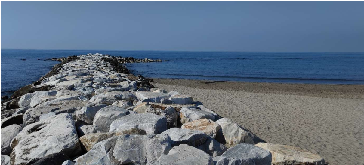
Figura 15 - Pennello e barriera soffolta presente nella Zona A
