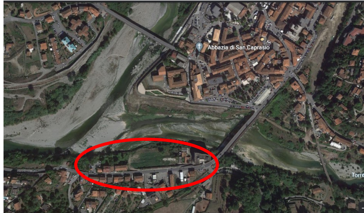
Localizzazione intervento su foto aerea
