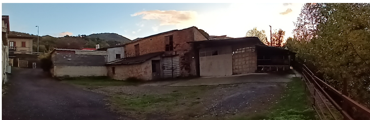
Immagine fabbricati costituenti l'aggregato edilizio A
