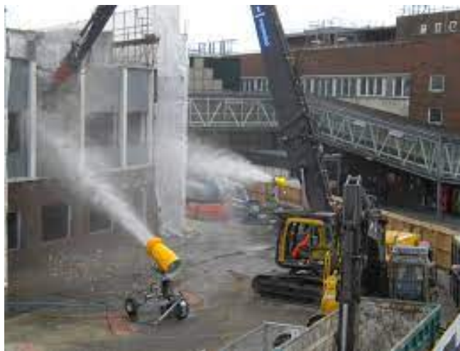
Immagine di cannoni nebulizzatori tipo, da impiegare nelle demolizioni
