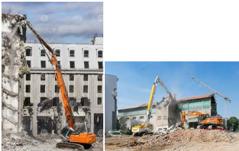
Immagine di escavatore con braccio snodato dotato di pinza demolitrice
