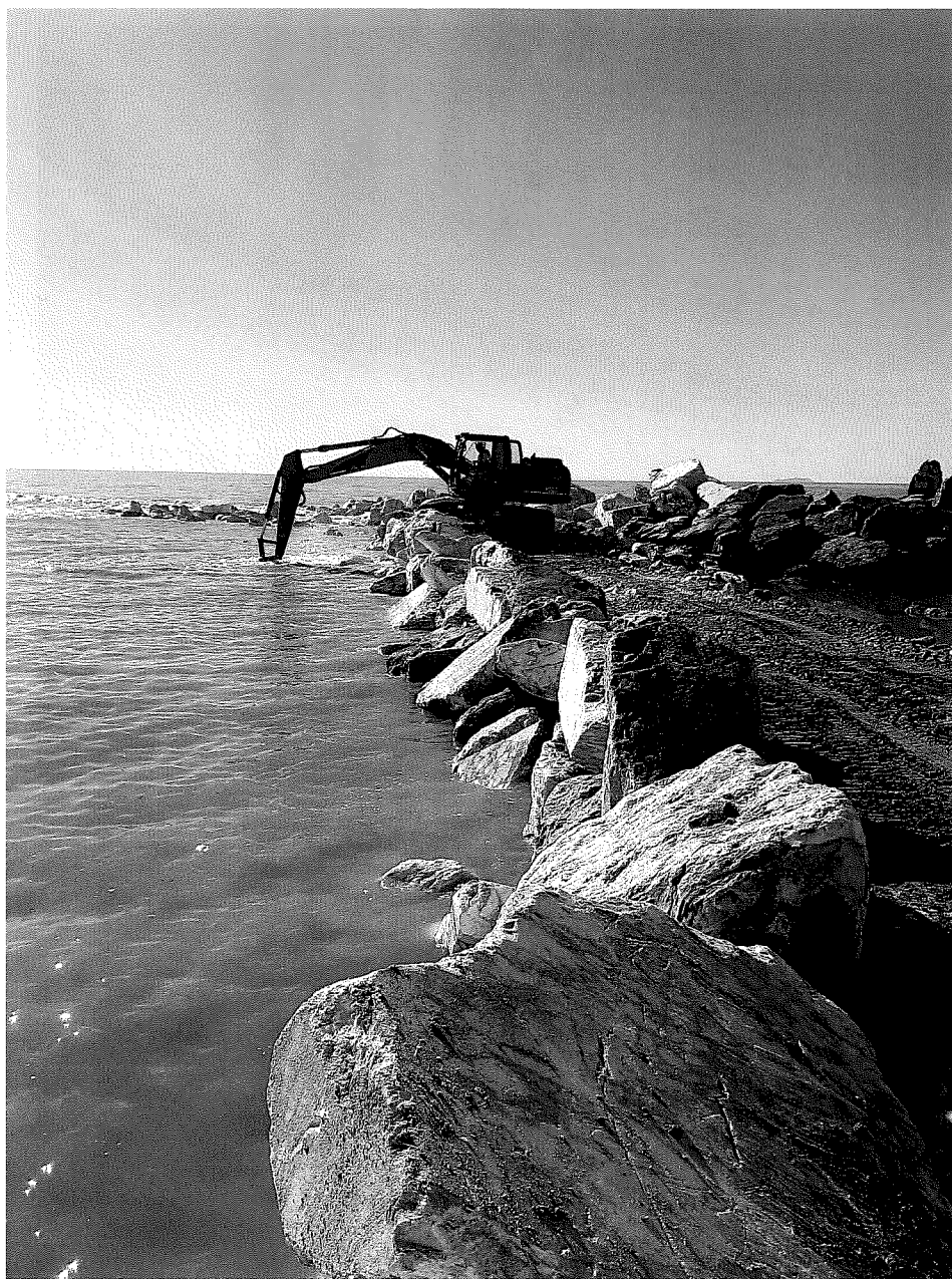
Foto n.3 Operazioni di ripristino pista di servizio post mareggiata 23-25 gennaio 2021
