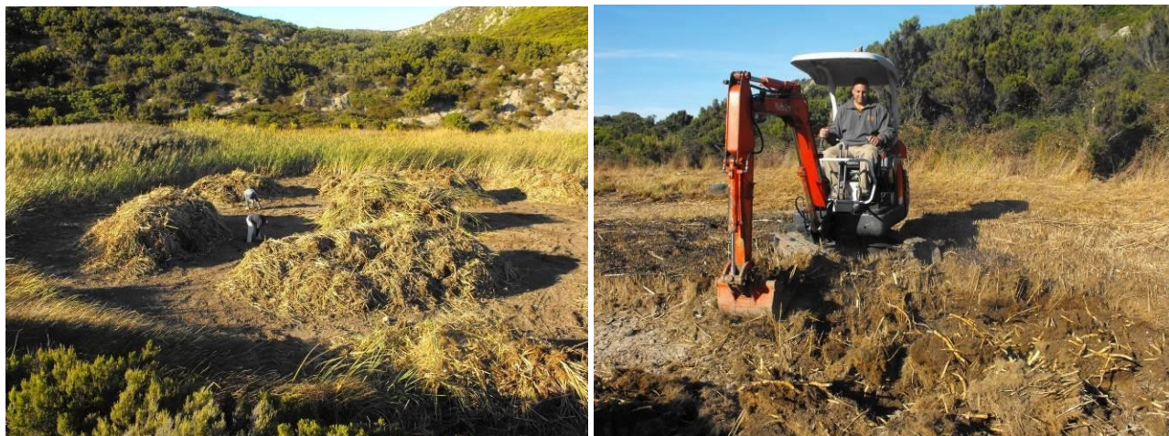
Figura 70 - Fasi delle lavorazioni (ottobre 2010). (Foto M. Giunti).
