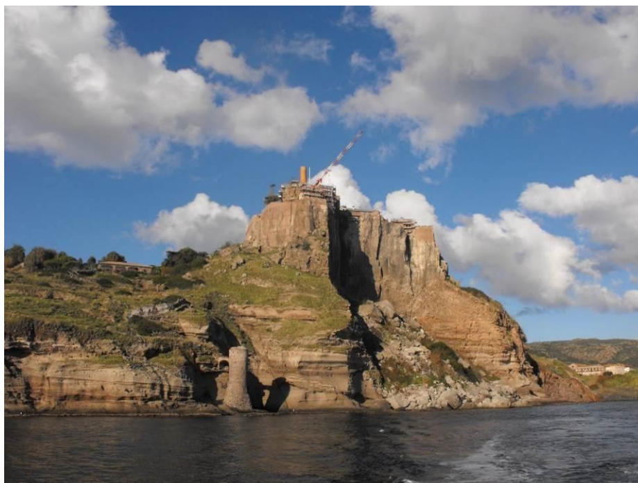
Figura 170 – Il Forte S.Giorgio in una foto del 2009 durante i lavori di restauro e ristrutturazione. (Foto M. Giunti)
