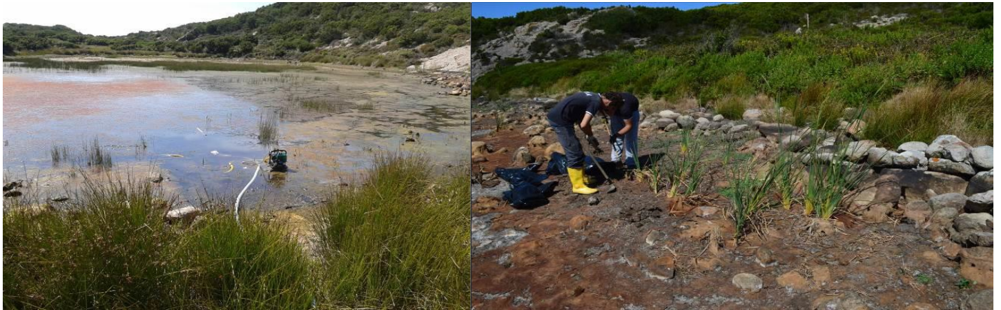
Figura 76 – Gli ultimi lavori eseguiti tra luglio (sx) e a settembre 2015 (dx). (Foto M. Giunti).
