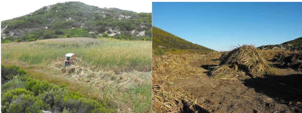
Figura 69 – Fasi delle lavorazioni (settembre 2010). (Foto M. Giunti).
