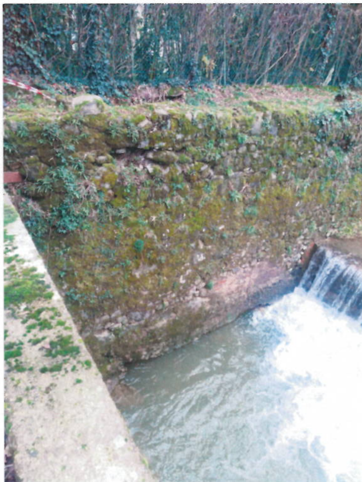
Dettaglio del muro di sponda in DX idraulica
