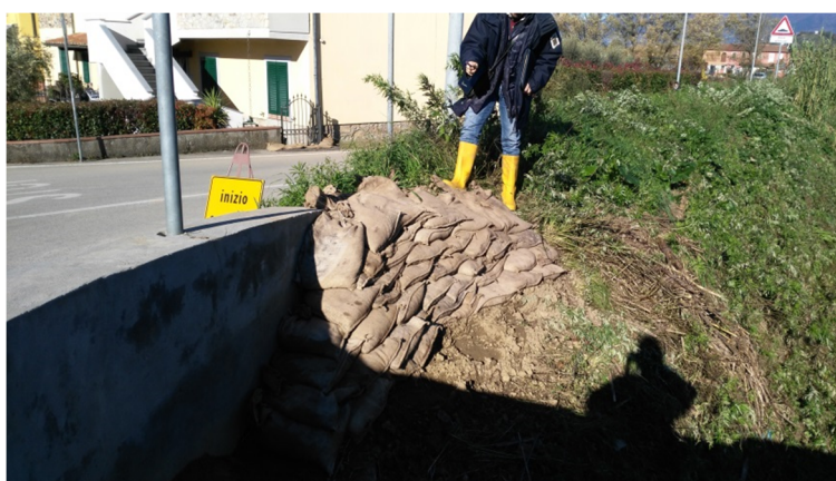
Figura 20: sacchini posizionati a protezione erosione
