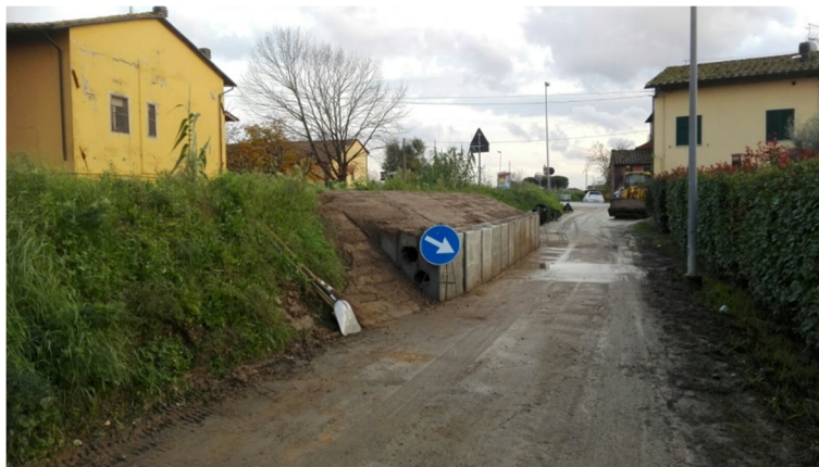
Figura 9: Intervento A ultimato
