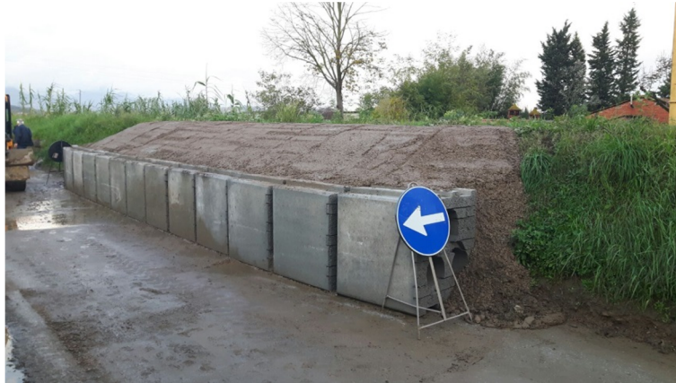
Figura 8: Intervento A ultimato
