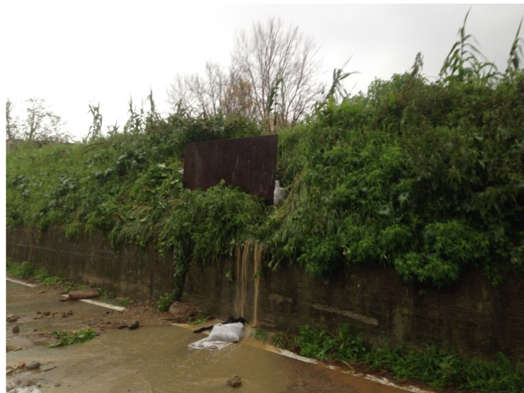
Figura 2: Lamiera infissa nell'argine per tamponare una rotta
