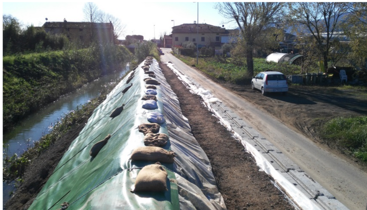
Figura 16: Intervento B con i teli di protezione
