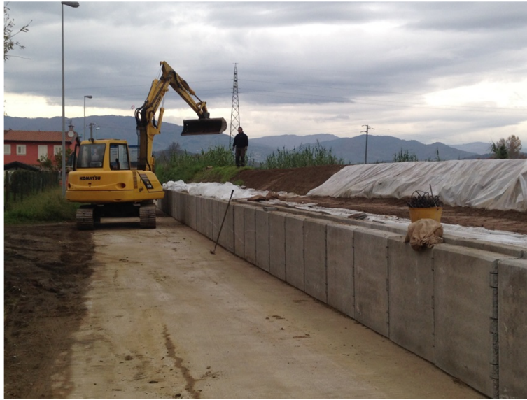
Figura 15: Intervento B in fase di esecuzione
