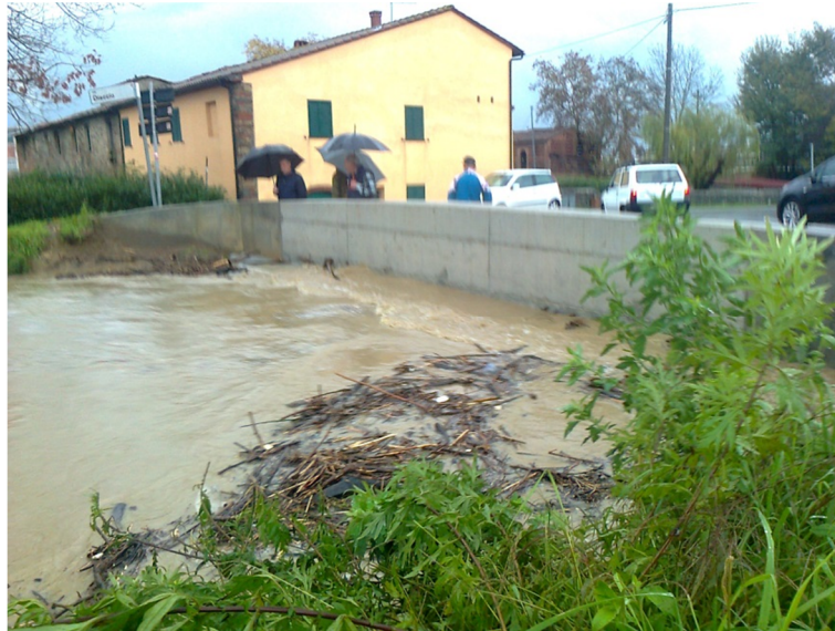
Figura 5: ponte di Via Diaccio sul Rio Leccio
