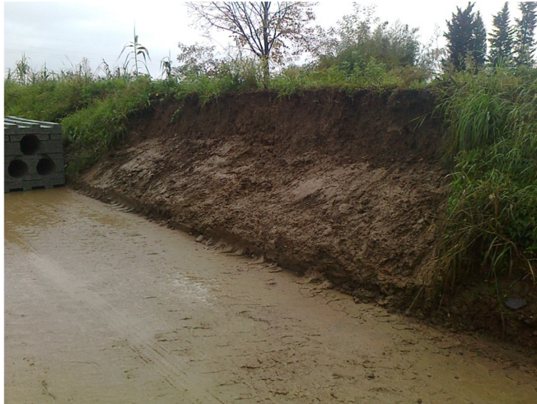
Figura 6: Intervento A durante l'esecuzione dei lavori
