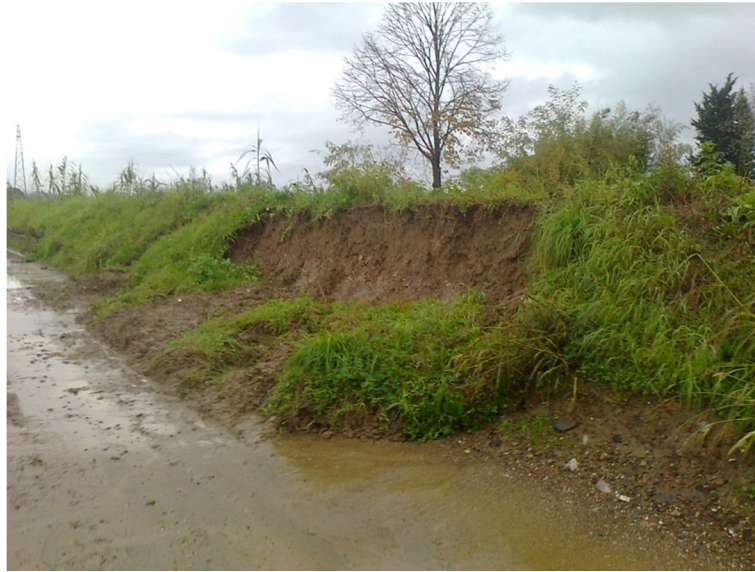
Figura 3: smottamento dell'arginatura in Via del Leccio
