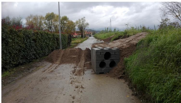
Figura 7: Intervento A durante l'esecuzione dei lavori
