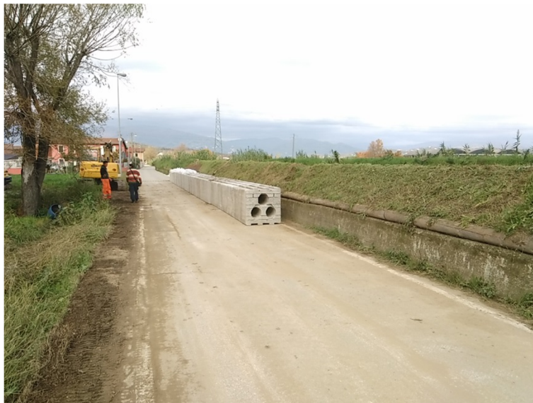
Figura 14: Intervento B in fase di esecuzione
