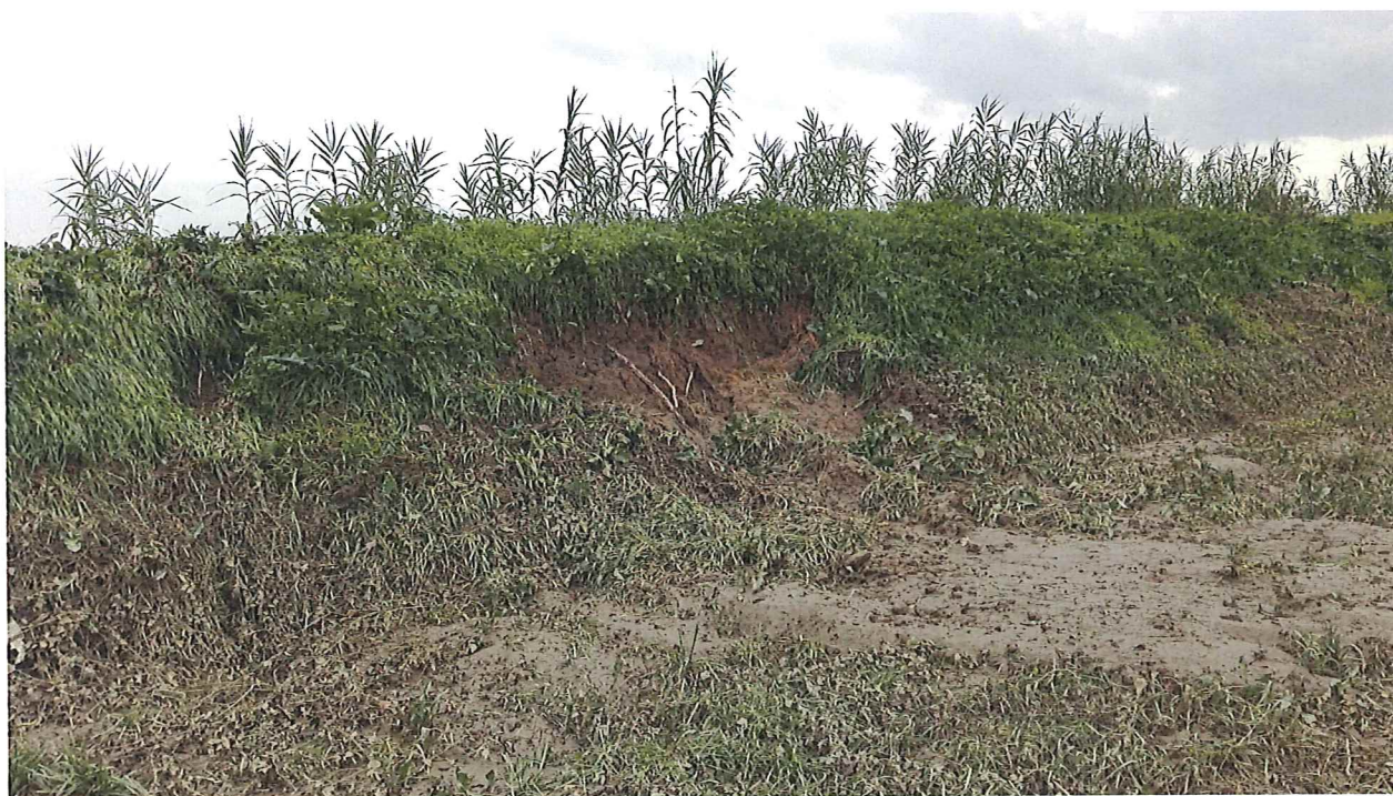
Vista del tratto di argine oggetto del sormonto
