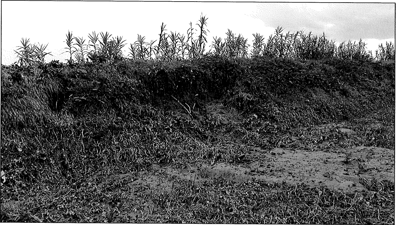
Vista argine Ralla nel tratto oggetto di sormonto da parte delle acque
