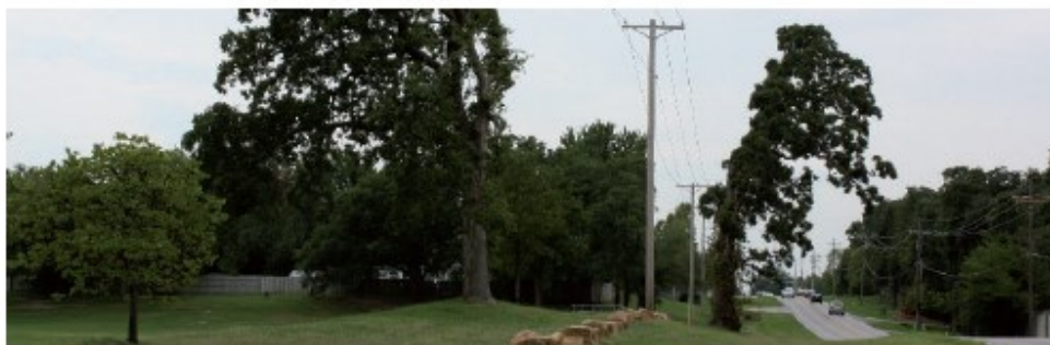
Fig.5c - Intervento di riduzione di chioma per risoluzione di conflitto, correttamente eseguito attuando tagli nodali
